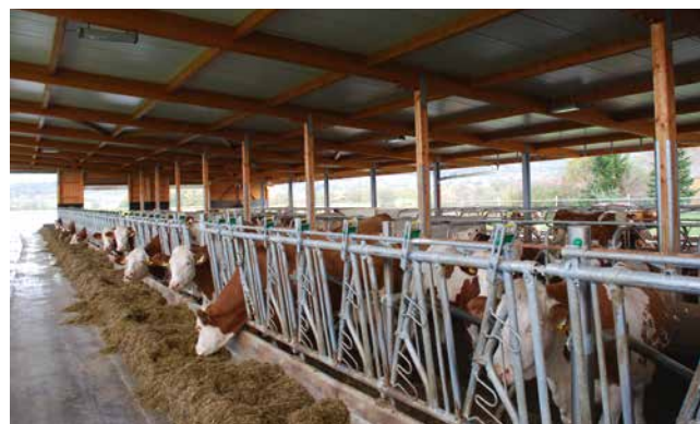
Der Pultdachstall der Familie Pöhlmann ist eine nicht gerade gängige Stallform, aber aufgrund der niedrigeren Bauweise fügt er sich gut ins Gelände ein.
